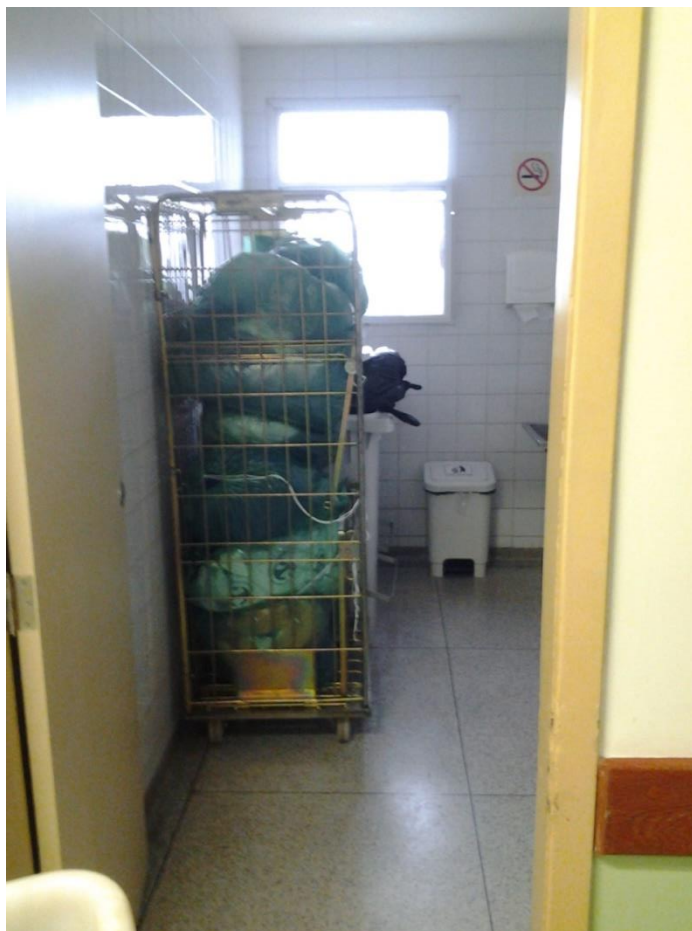
Figura 4.8 – Abrigo interno do Hospital Municipal Universitário Fonte: Fotografia retirada pelo autor desta tese.
