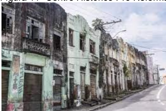
Figura 11- Centro Histórico Pré Reforma
