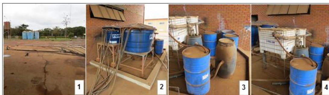
Figura 60 Processo de “remediação” de vazamento de óleo.
