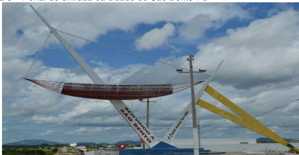
Figura 5 – Portal de entrada da cidade de São Bento-PB
