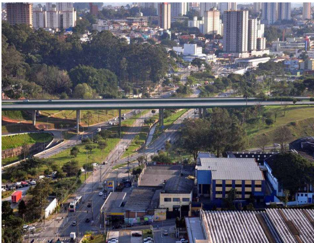
Figura 3 - Vista da parte central do Município de Diadema
